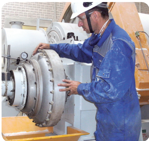
Reforma de Acoplamentos
